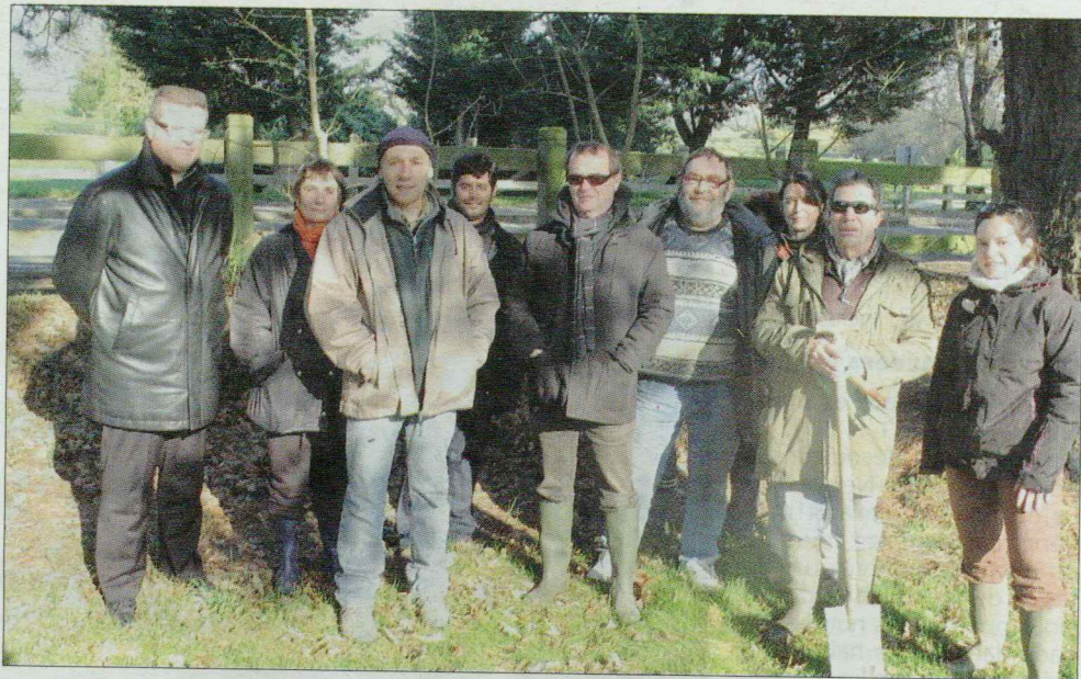
Les bénévoles de l'association Hironnelle qui ont construit le week-end dernier un crapauduc le long du golf
